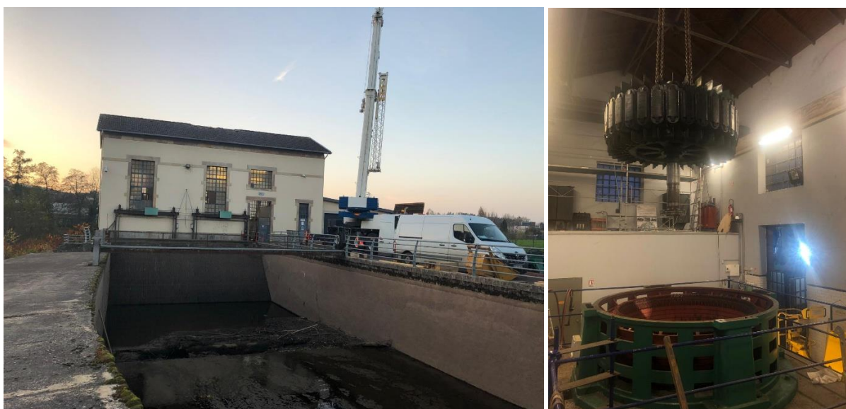
Photos de chantier : mise assec de la centrale, démontage des alternateurs et des turbines, grutage (novembre 2024)
